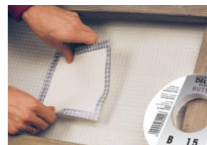
DELTA®-BUTYL-BAND Двусторонняя, армированная лента из бутилкаучука.
