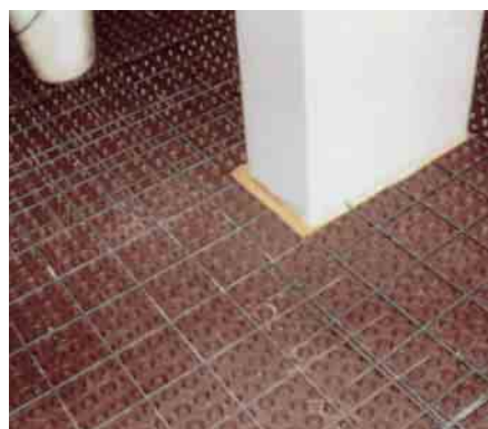
Установленные между плитой перекрытия и дорожной поверхностью листы DELTA®-MS 20 улавливают любую проникающую воду, появляющуюся в результате подъема уровня грунтовых вод, и передают ее в дренажную трубу.
