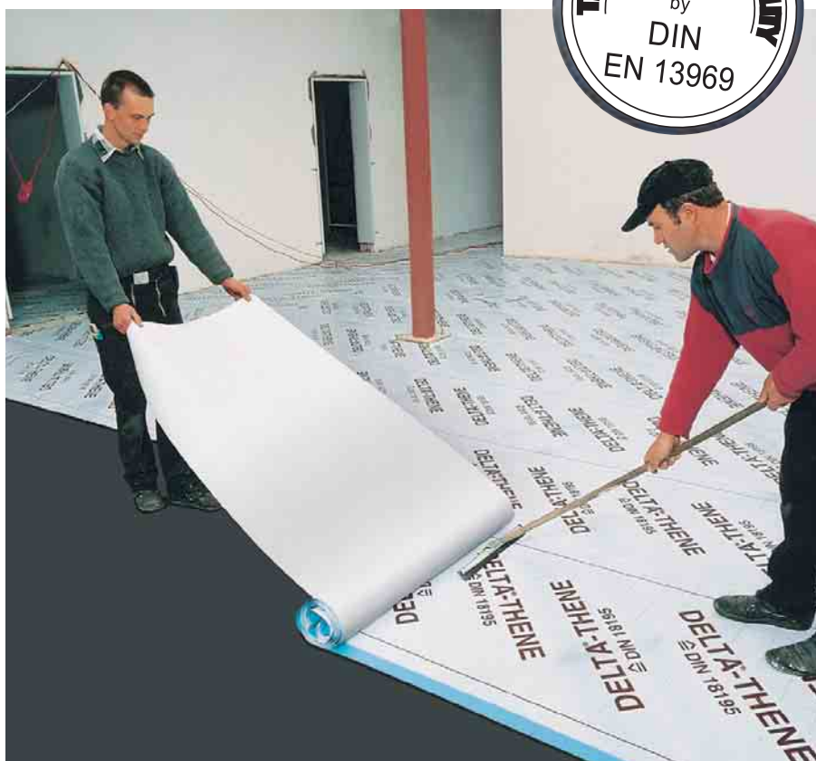
Большие поверхности можно легко и быстро изолировать с помощью рулонов DELTA®-THENE.
