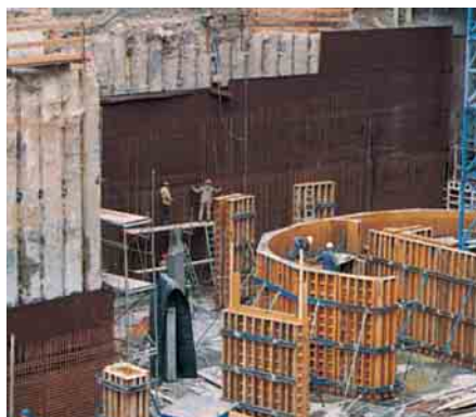
Подземный гараж гостиницы во Франкфурте: Вода, проникающая сквозь скалистую почву, выводится с помощью мембраны DELTA®-MS.
